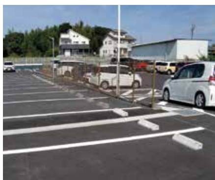
●本地こども園駐車場増設
