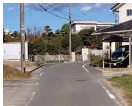
●本地新田区民館前の排水路整備
