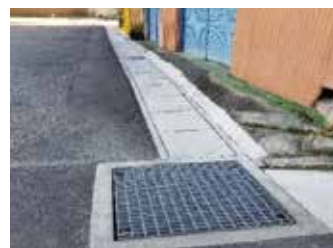
●宮新3丁目側溝整備
