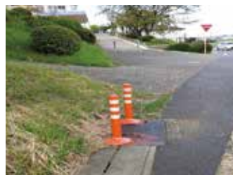
●宮口こども園道路排水路升工事
