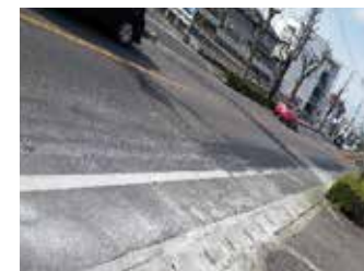
●日南町舗装工事
