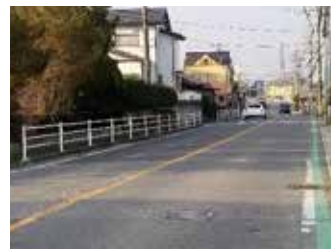
●旧セブンイレブン北側舗道パイプ設置
