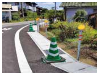
●宮口一色道路路肩整備
