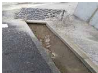
●天王団地内側溝工事
