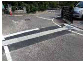
●宮上緑苑内側溝整備
